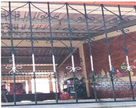
Foto 3: Proceso, Sustitucion de ventanas de marcos metalicos
