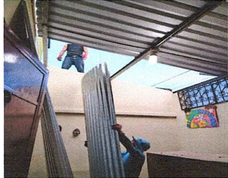
Foto 2: Proceso, Cambio de lamina por deterioro
