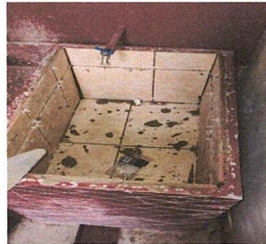
Foto 4: Proceso, cuando ya estna colocando el azulejo a la pila#1
