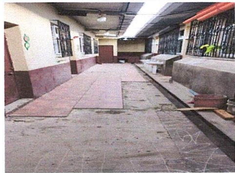
Foto 6: Proceso, cuando se colocan la losa al piso
