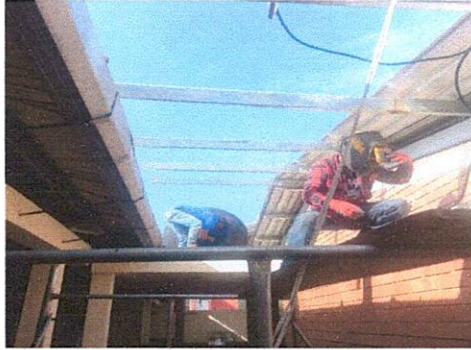
Foto 1: Proceso, Colocando costeneras
